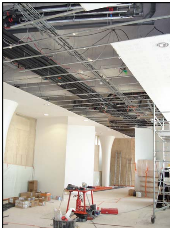
Lors des travaux de la salle basse du restaurant.
